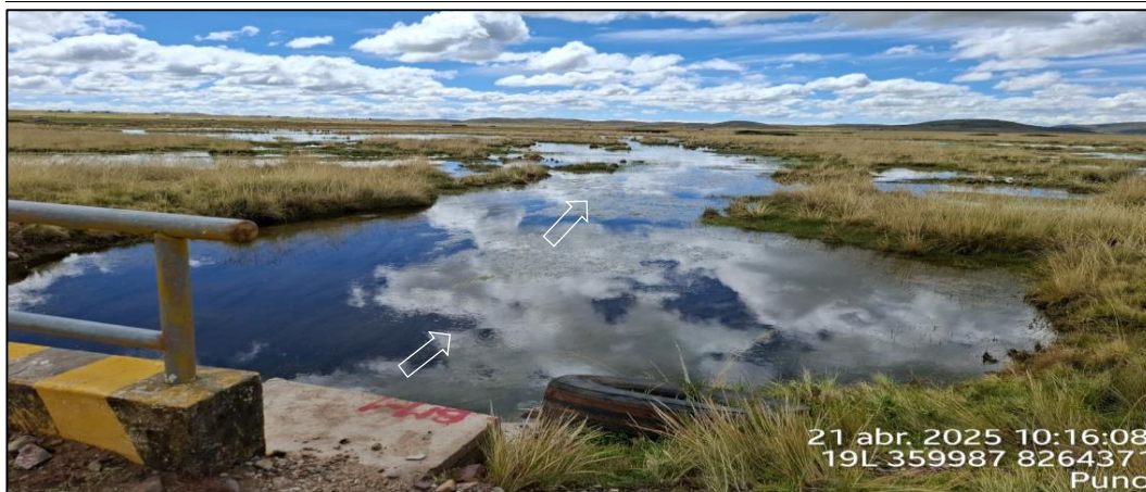
FIGURA 2: TRAMO CRÍTICO EN EL RÍO PUCAMAYO. NOTESE, EL DESBORDE E INUNDACION A CAUSA DE LA SEDIMENTACION QUE REDUCE LA SECCION HIDRAULICA DEL CAUCE DEL RIO, A INICIOS DEL CAUCE AGUAS ABAJO DEL PUENTE TIRACOMA.
